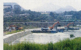
相模ダム浚渫
